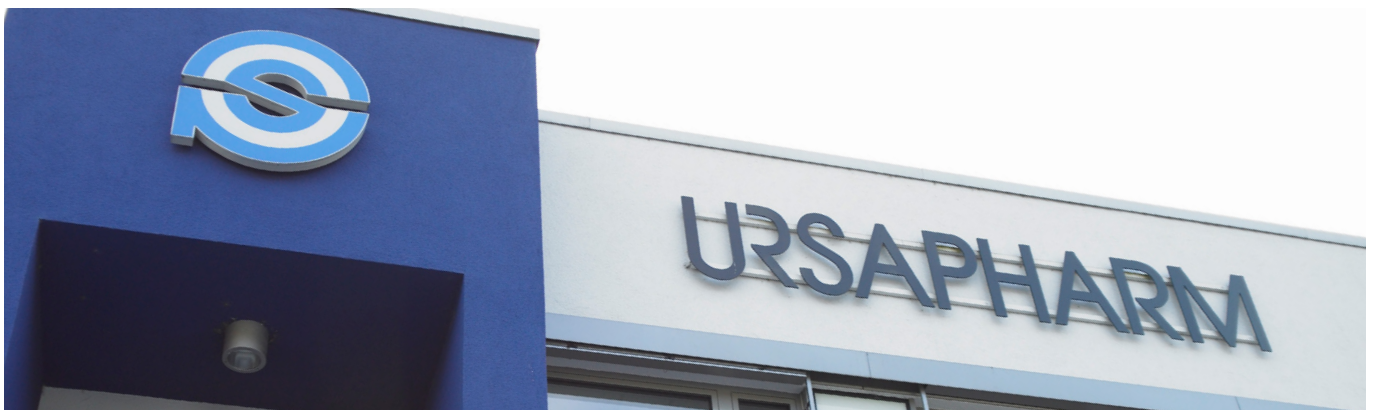
Ursapharm setzt auf eine moderne, förderfähige Kälteanlage von Johnson Controls, bei der das natürliche Kältemittel R717 zum Einsatz kommt. (Bild: Ursapharm)
